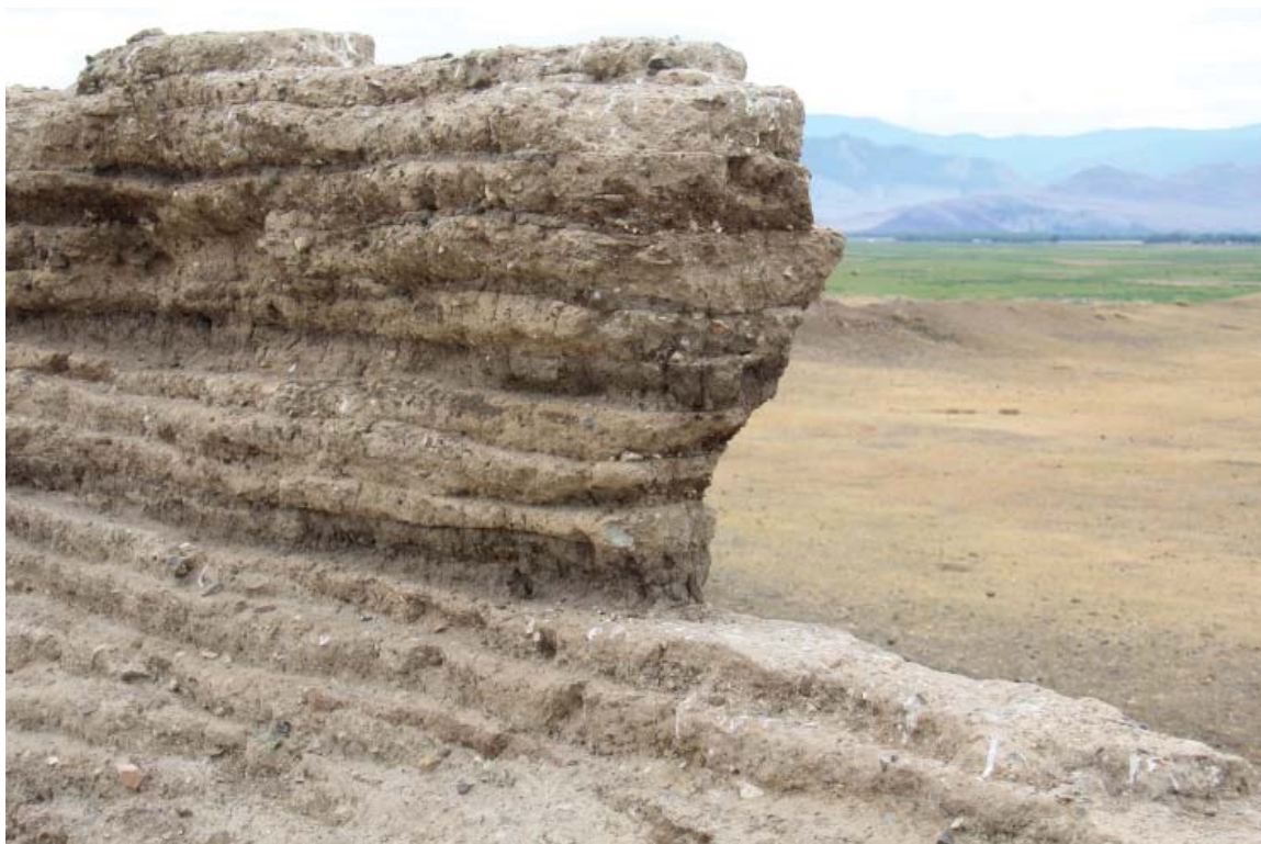
Рис. 8. Западный край северной стены. Fig. 8. Western edge of the north wall.
