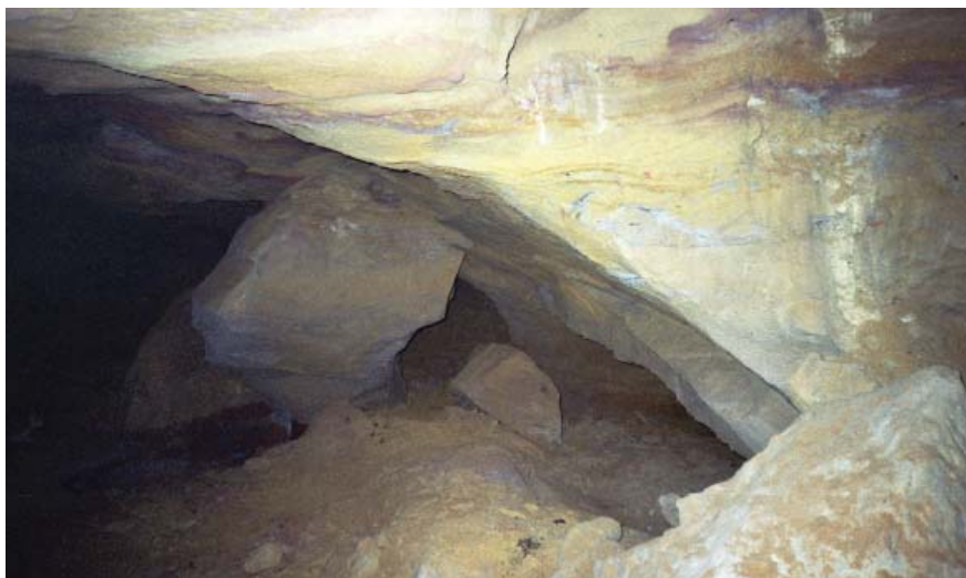
Рис. 14. Каргалы, Мясниковский овраг, участок IV. Подземные выработки. Дальнейший ход перекрыт упавшими частями свода. Начало июля 2002 г.
