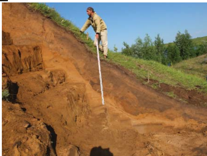
Рис. 47. Стенка срыва и оползни, образованные при углублении седловины для строительства дороги жителями д. Маклашеевка в XIX в.
