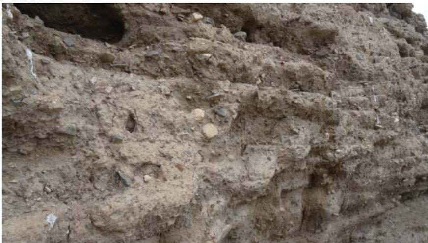
**Рис. 9.** Деталь восточной стены из ленточного бетона.
