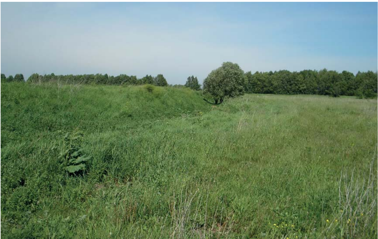
Рис. 20. Кокрятское городище. Вид с юго-востока на оборонительную линию
