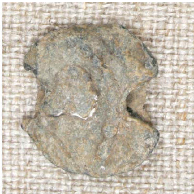
Рис. 6. Образование белых порошковых продуктов коррозии в трещине на свинцовой пломбе.
