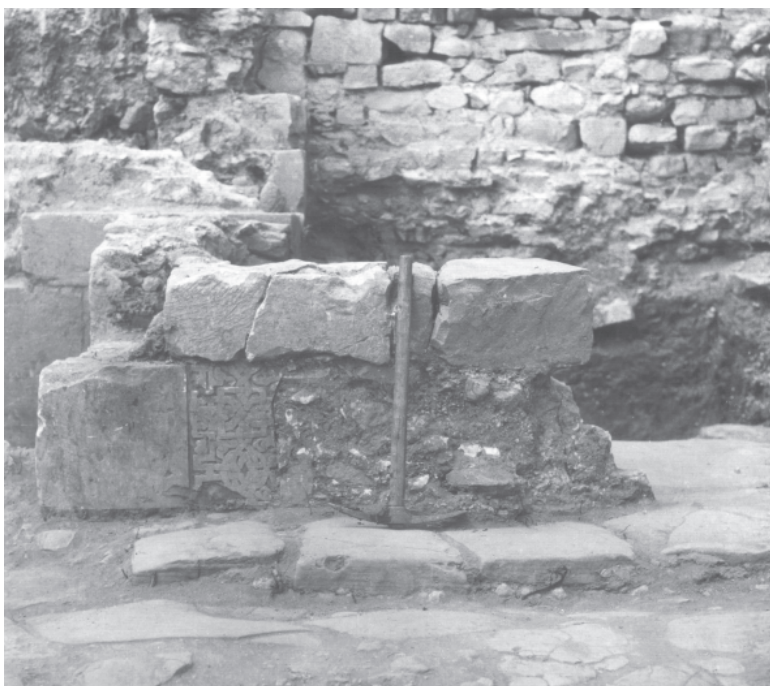
Рис. 3. «Подпорная стенка некрополя (?)». Вид с востока. Снимок 1980 г. (по: Крамаровский, 1981, л. 86, табл. VII, 2). Fig. 3. “Support wall of the necropolis (?)”. View from the east. Photo from 1980 (after Kramarovsky, 1981, sheet 86, table VII, 2).
